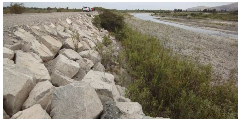
base de enrocado erosionado con perdida de roca en 1.5 m aproximadamente
