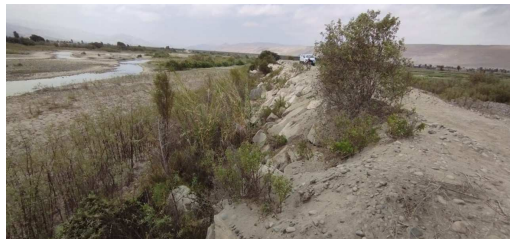
vista panoramica de dique,socavacionen base de enrocado
